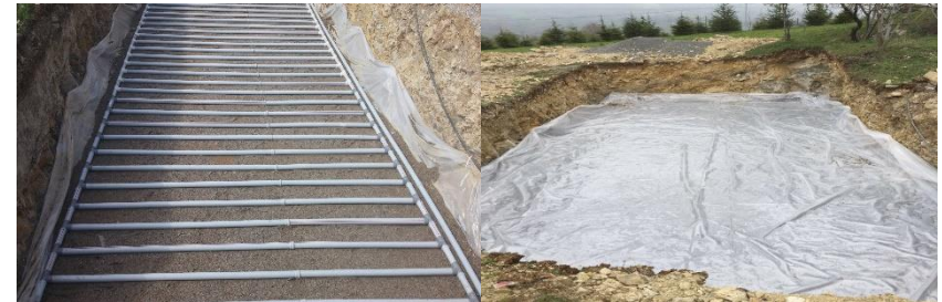
Yeraltı Boru Sisteminin Kurulumu Ve Yapay Havuz
